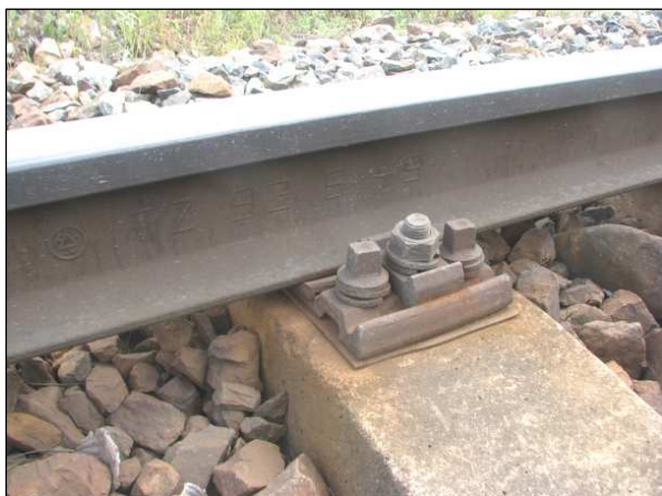
Detail železničního svršku, širá trať
