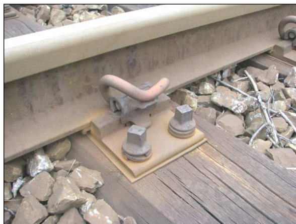
Detail železničního svršku, zhlaví ŽST
